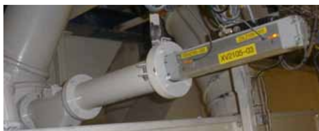
Prise d'échantillon sur conduit gravitaire
